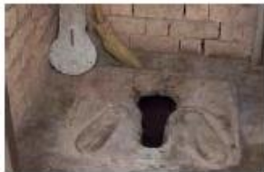
a) Pit latrines
